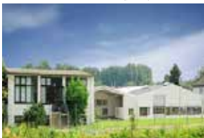
AKG Thermotechnik GmbH & Co. KG Hofgeismar, Germany
