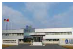
AKG Thermal Systems (Taicang) Co., Ltd., Taicang, China
