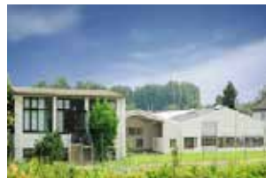
AKG Thermotechnik GmbH & Co. KG Hofgeismar, Germany
